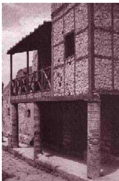
Ercolano - Casa del Graticcio. Si tratta di un ottimo esempio di edilizia in materiale effimero: i muri sono infatti rivestiti di pietre ma hanno un'anima in paglia e fango che viene mantenuta compatta dalla intelaiatura lignea.
