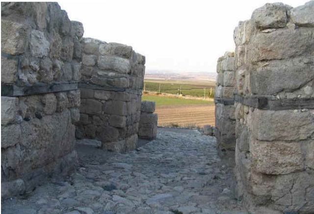
Fig. 20 – Ingresso della porta a “sei compartimenti” di età israelitica presso la cittadella di Megiddo; fig. 21 – Planimetria della porta con chiara indicazione dei vani nel fornice principale.
